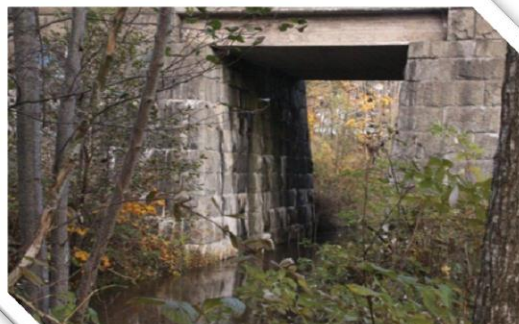
Järnvägsbron vid Holmby reningssverk. Foto; Bertil Karlsson
